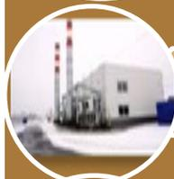
Создание миниТЭЦ на базе реконструкции котельных с установкой паровых турбогенераторов (Южно-Кузбасская энергетическая компания)
